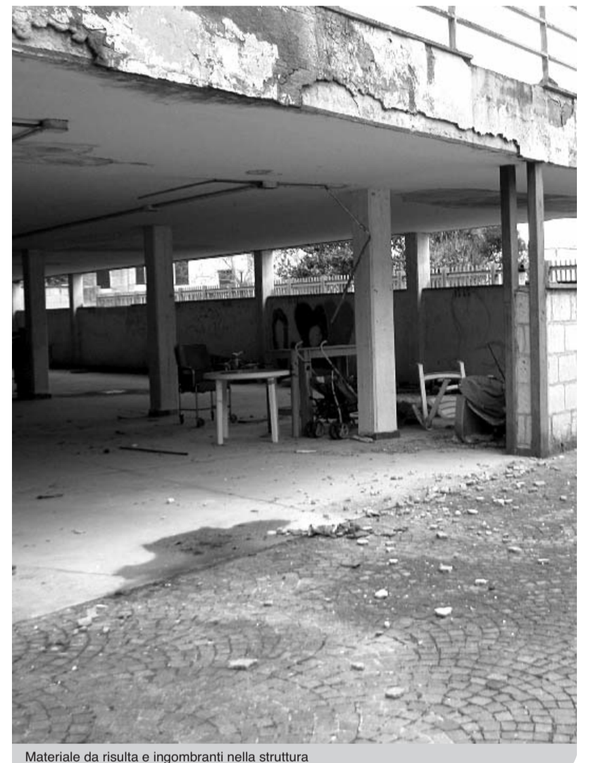
Materiale da risulta e ingombranti nella struttura
